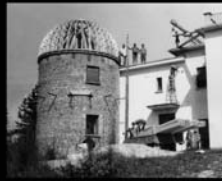
Izgradnja Astronomsko-geofizikalnega observatorija na Golovcu je potekala v letih 1950-1959. Najprej so adaptirali obstoječo stavbo, priložni k obstoječi stavbi pa je bil dokončan leta 1956. Sledila je razširitev zahtevna izgradnja observatorijskega dela, saj je potreba celotno za teleskop posebej izdelani in ločeni od stavbe.
