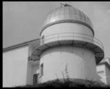
Dokončana stavba observatorija (posnetek iz začetka 60. let). Observatorij je začel z delom leta 1959. Delil se je na dva sektorja, astronomskega in geofizikalnega, ključna je bila skrbna izbira območja in opremljanje in opremljanje. Stavbo je postavil dr. Fran Dominko.
