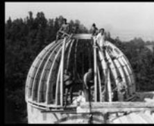
Leta 1959 je bila zgrajena 5,5-metrski kupola, v katero so leta 1960 montirali 15-centimetrski refraktor Askania, ki so ga večletno uporabljali za opazovanja Sonca. Gradnja 5,5-metrski kupole potekala leta 1958 in bila je v takratnem času zahtevna tehnološki podvig.
